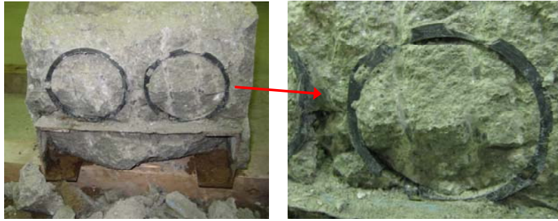
写真 1-2-4 コンクリート置換充填状況
