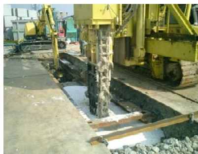
上：気泡添加による掘削状況 右：プレキャスト部材の建込み状況
