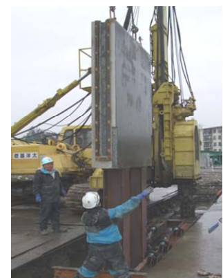
写真-3 AWARD-Trend 工法の施工状況
