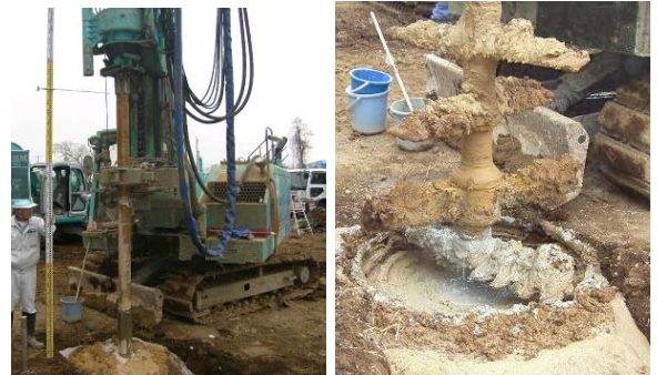
写真-1 施工機械 写真-2 施工完了状況
