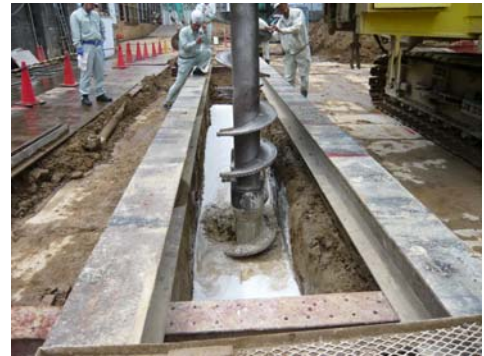
写真-3 施工状況
