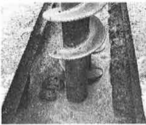
気泡工法によってソイルセメント地中壁を構築する様子
